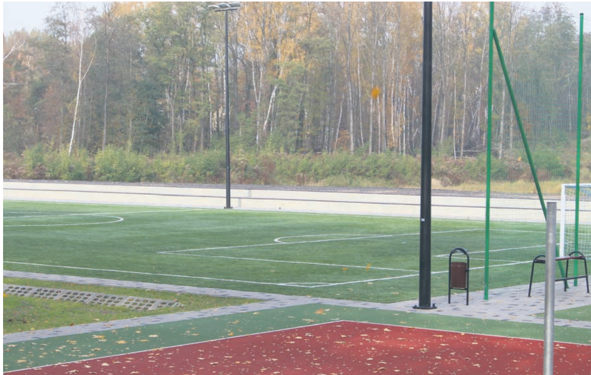
Przy boisku zostaną zamontowane piłkochwyty.
