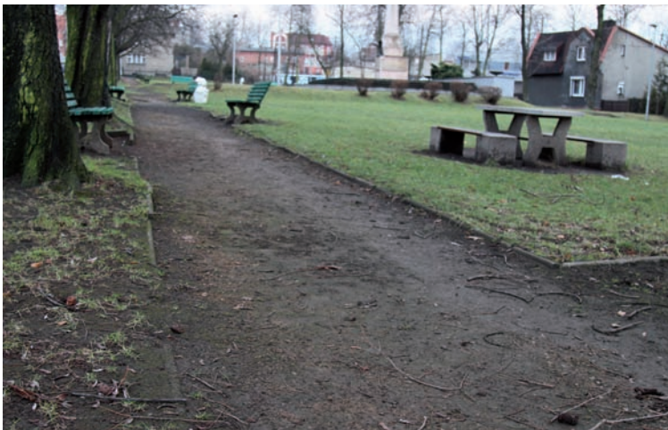
Alejki żwirowe zastępują betonową kostkę.
