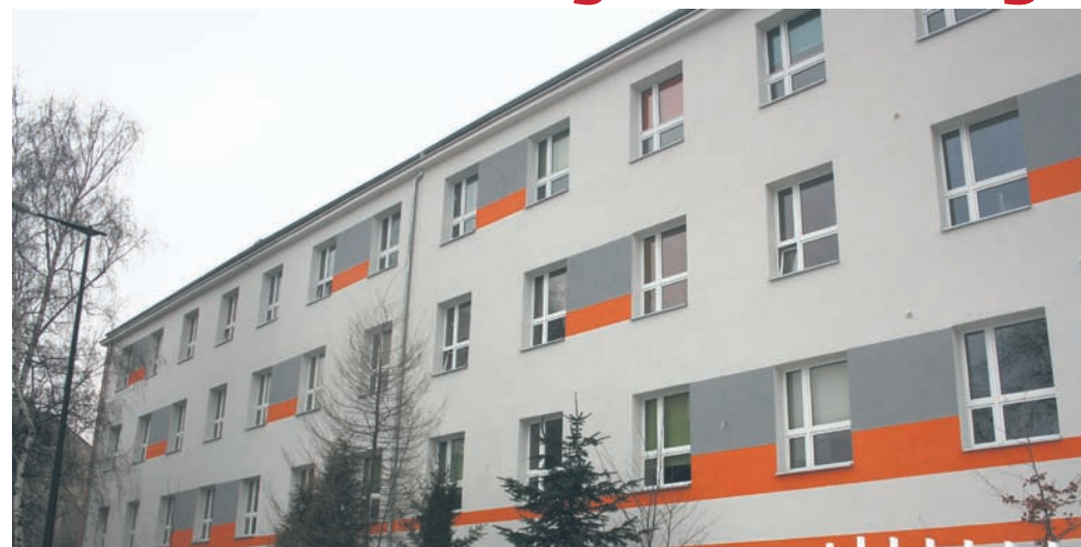
Nowa elewacja ZSP nr 4 nawiązuje kolorystycznie do pobliskiej SP nr 4, podobnie będzie po termomodernizacji z MP nr 18.
