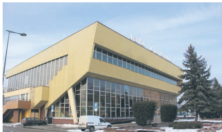
Budynek hali ma doczekać się modernizacji.
