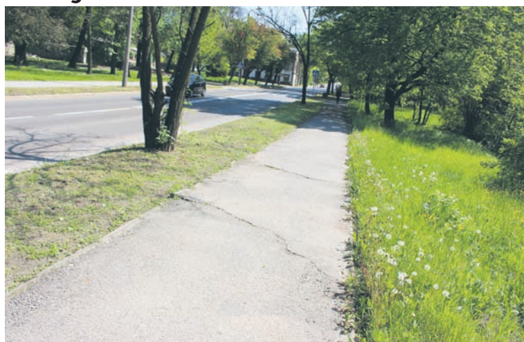
Na remont tego fragmentu chodnika mieszkańcy muszą poczekać.
