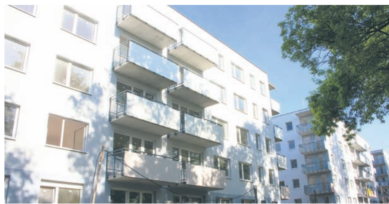
Budowa mieszkań przy ul. Kędzierzyńskiej i Czempieła ma się zakończyć w lipcu.
