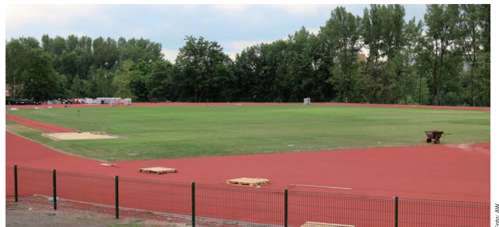
Budowa stadionu lekkoatletycznego dobiega końca.
