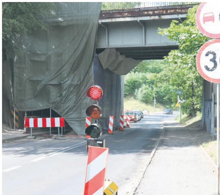
Z powodu remontu wiaduktu na ul. Tunkla tworzą się korki.
