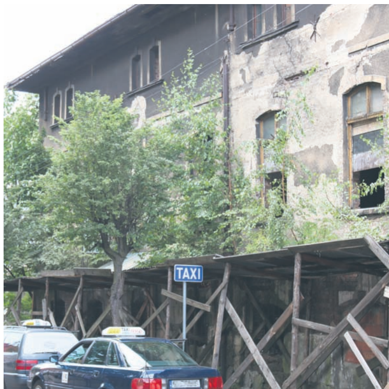
Do zawalenia się stropu doszło w ubiegłą środę.
