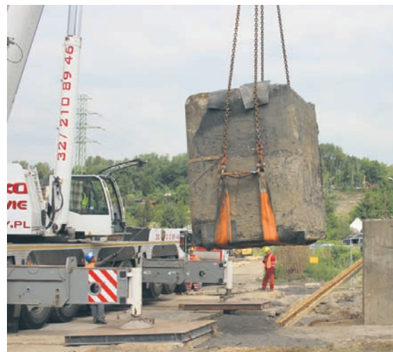
300-tonowy dźwig przeniósł żelbetowy schron.
