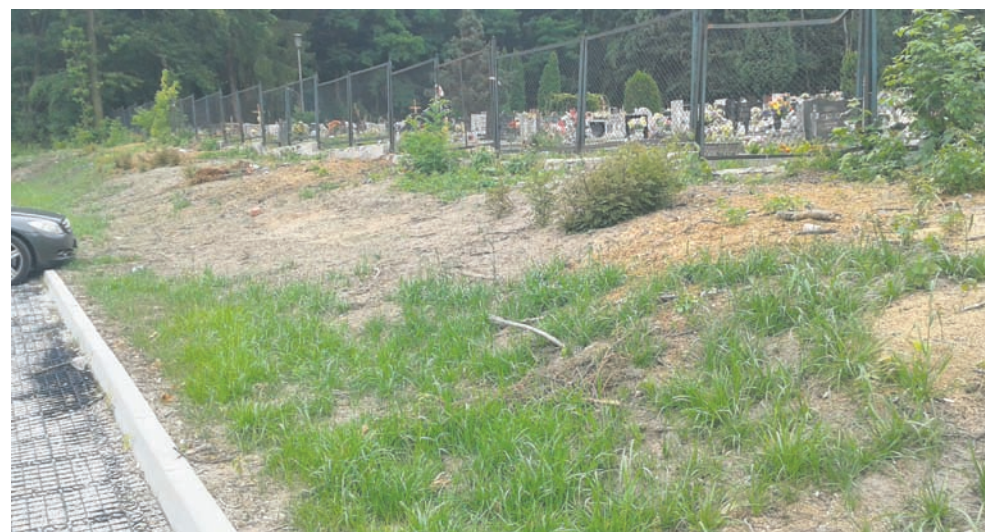
MPGM TBS rozpoczęło także prace nad ukrzewieniem skarpy przy ul. 1 Maja.
