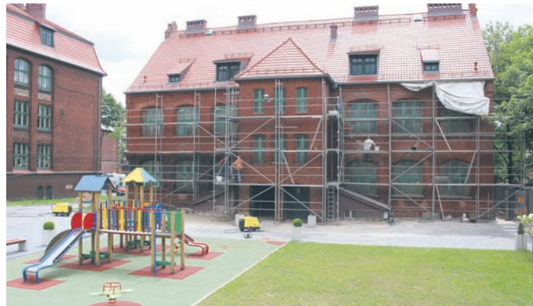
W czasie wakacji trwa m.in. termomodernizacja SP nr 14.
