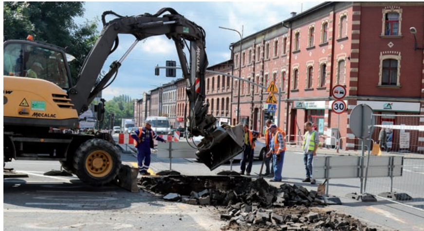
Remont torowiska w obrębie skrzyżowania potrwa około dwóch tygodni.
