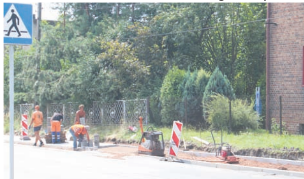
W Kochłowicach przy ul. Tunkla trwa budowa chodnika.
