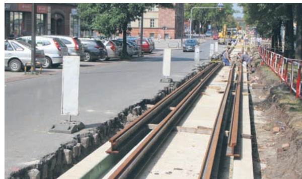
Modernizacja torowiska w Nowym Bytomiu idzie zgodnie z planem.
