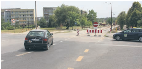
Remont ul. Górnośląskiej potrwa do grudnia.
