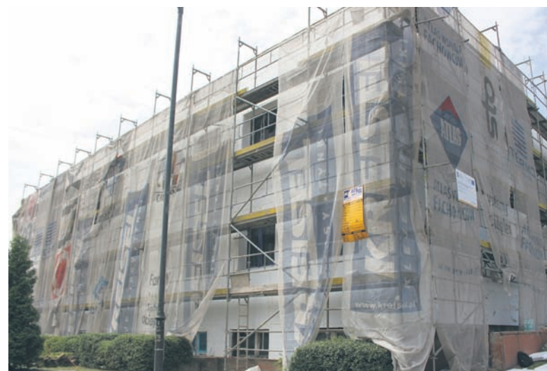
Prace związane z termomodernizacją prowadzone są także w przychodni przy ul. Siekiela.
