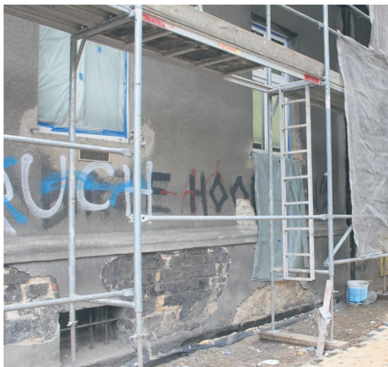
Remont budynku sanepidu zakończy się w październiku tego roku.
