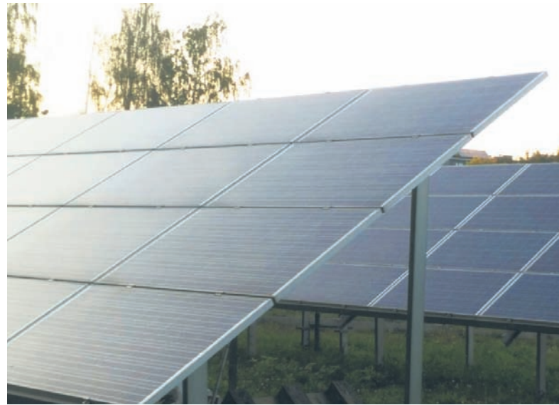
Jeszcze w tym roku na trzech miejskich budynkach użyteczności publicznej zamontowane zostaną instalacje fotowoltaiczne.
