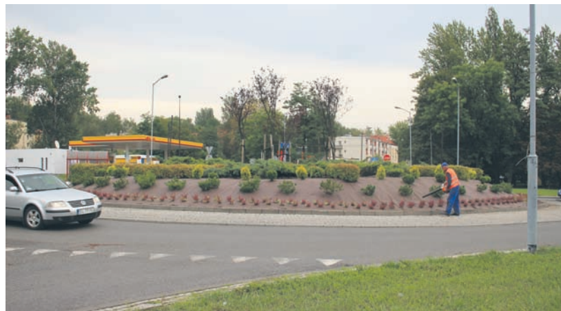
Na rondzie przy Shellu trwają końcowe prace.
