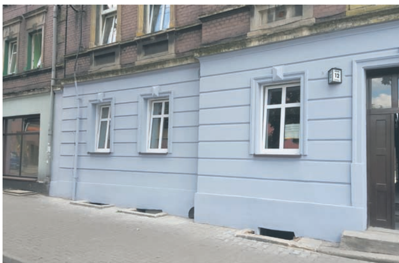
Roboty MPGM TBS obejmują również odnowę elewacji.
