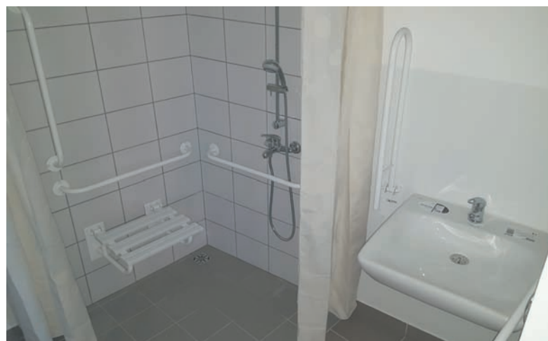
Gdy jest taka potrzeba, w ramach prac kompleksowo remontowane są także mieszkania.
