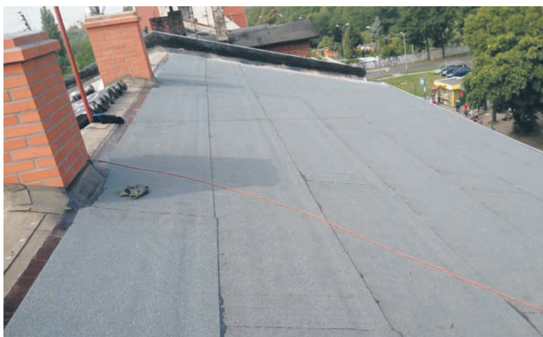
MPGM TBS w ramach corocznego planu m.in. remontuje dachy budynków.
