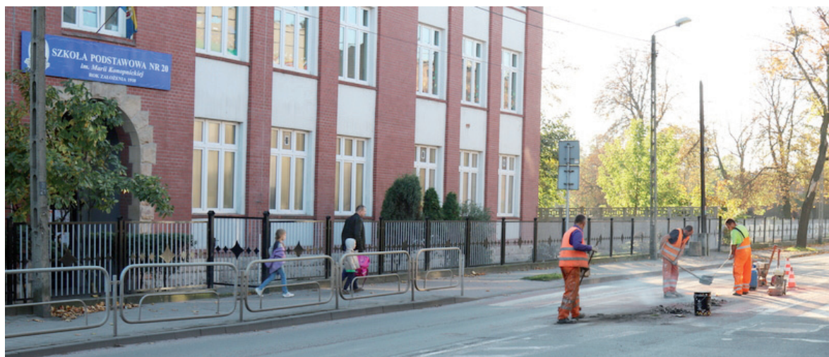
Ekipy remontowe pojawiły się już na ulicy Wyzwolenia.
