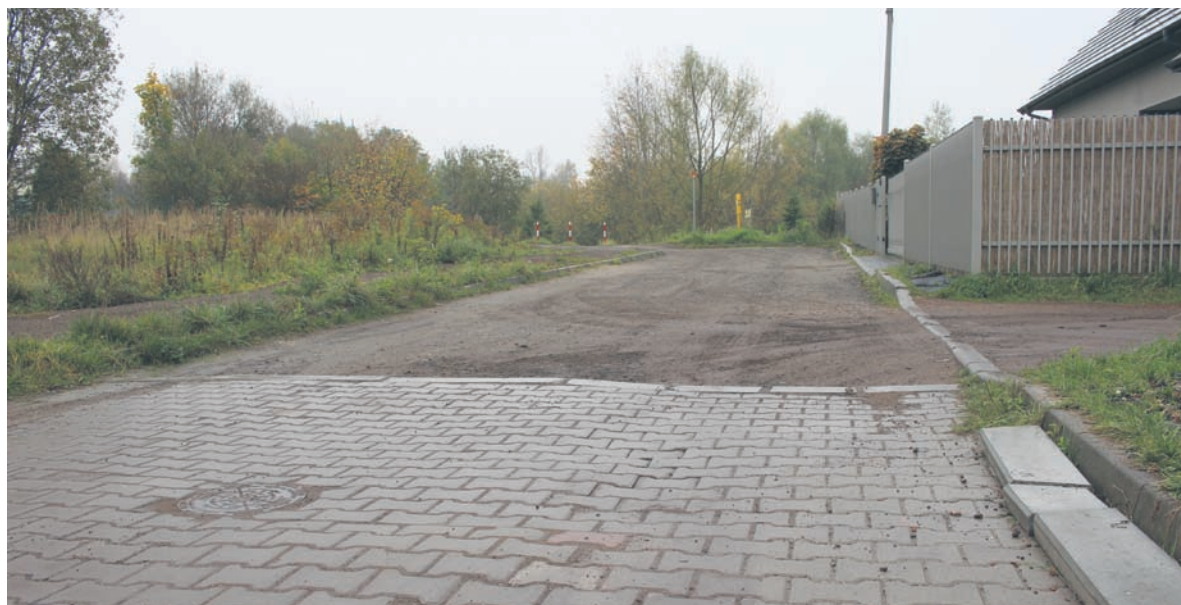
Nieutwardzona część ul. Zjednoczenia zyska nową nawierzchnię z kostki.
