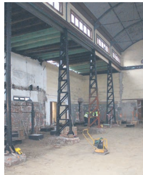
Wewnątrz budynku dworca trwają intensywne prace.
