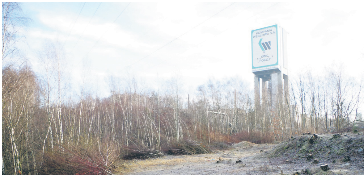
Rozpoczęły się już pierwsze prace przy rewitalizacji hałdy przy ul. 1 Maja.
