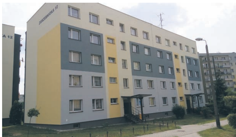
W ramach ubiegłorocznych termomodernizacji budynków wspólnot wyremontowany został m.in. ten przy ul. Zgrzebnioka 10.
