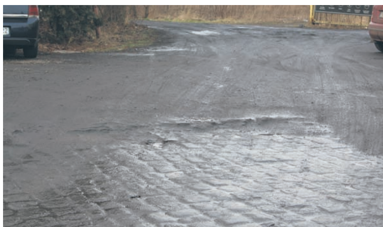
Droga prowadząca do basenu przy ul. Ratowników jest w kiepskim stanie.
