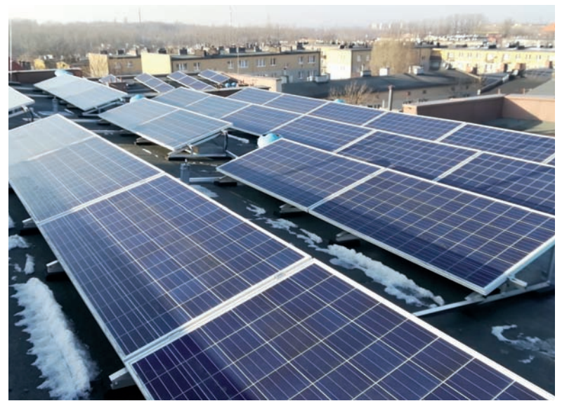
Na dachu budynku Urzędu Miasta przy pl. Jana Pawła II zainstalowano ponad 100 modułów fotowoltaicznych.
