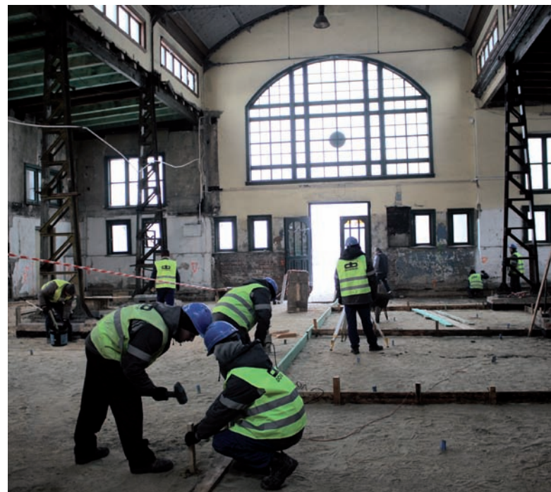
Trwają intensywne prace przy rewitalizacji dworca PKP w Chebziu. Inwestycja ma być gotowa jesienią.
