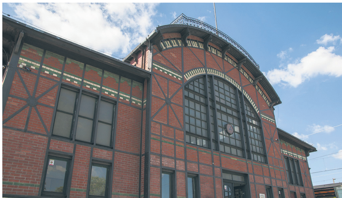
Kompleksowa rewitalizacja dworca polega przede wszystkim na adaptacji wnętrza budynku pod bibliotekę.
