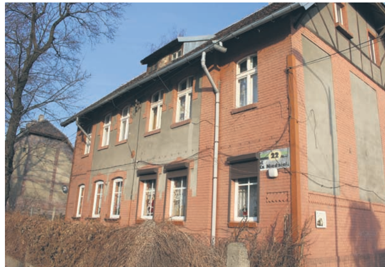
Na remont budynku przy ul. ks. Józefa Niedzieli 22 miasto przekaże 140 tys. zł.
