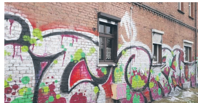
Pod koniec lutego wandalę zniszczyli elewację budynku przy ul. 1 Maja w Halembie.
