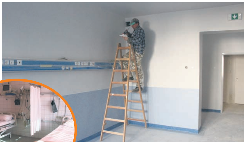
Trwa remont w pomieszczeniach Oddziału Kardiologii.
