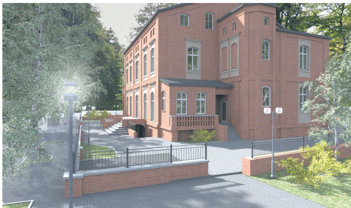
Remont budynku ma się zakończyć w połowie 2019 roku.
