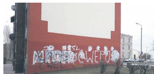
To jeden ze zniszczonych napisami budynków w Wirku przy ul. 1 Maja.
