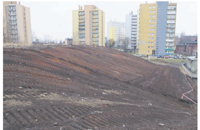
Realizowany od stycznia pierwszy etap rewitalizacji hałdy obejmuje głównie prace ziemne.
