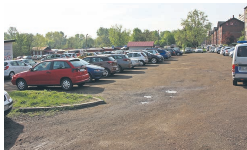
W tym miejscu powstanie parking z prawdziwego zdarzenia.
