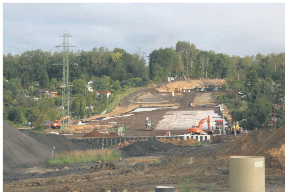
Budowa trzeciego etapu trasy N-S rozpoczęła się w 2017 r. Odcinek ma być gotowy pod koniec tego roku.
