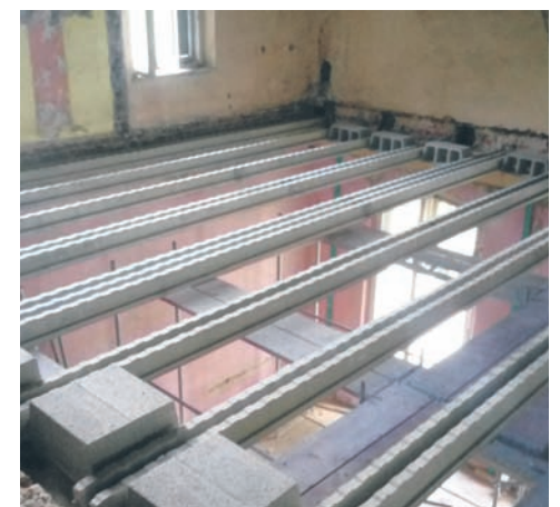
W środku prowadzona jest kompleksowa przebudowa.
