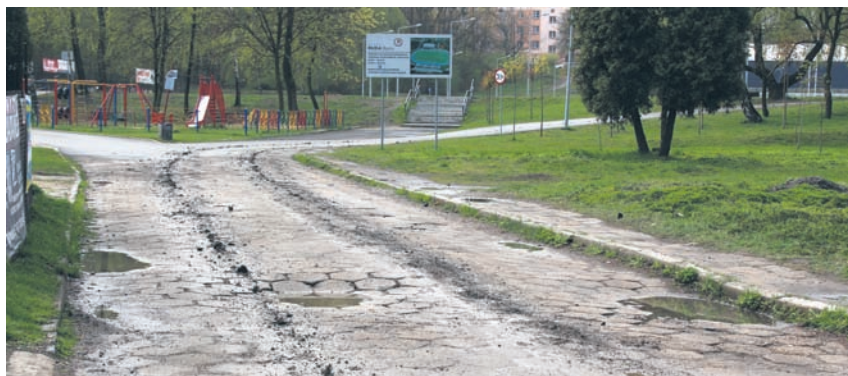
Droga dojazdowa do Burloch Areny jest w złym stanie.
