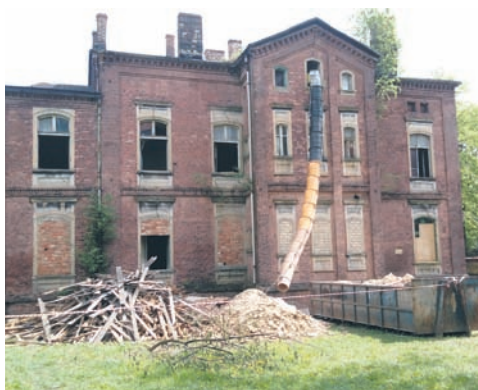
Obecnie w budynku przy ul. Niedurnego 75 trwa remont.
