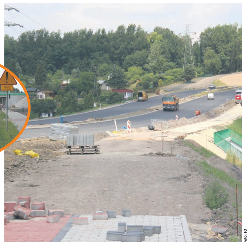
Obecnie trwają prace w pobliżu ul. Kokota.
