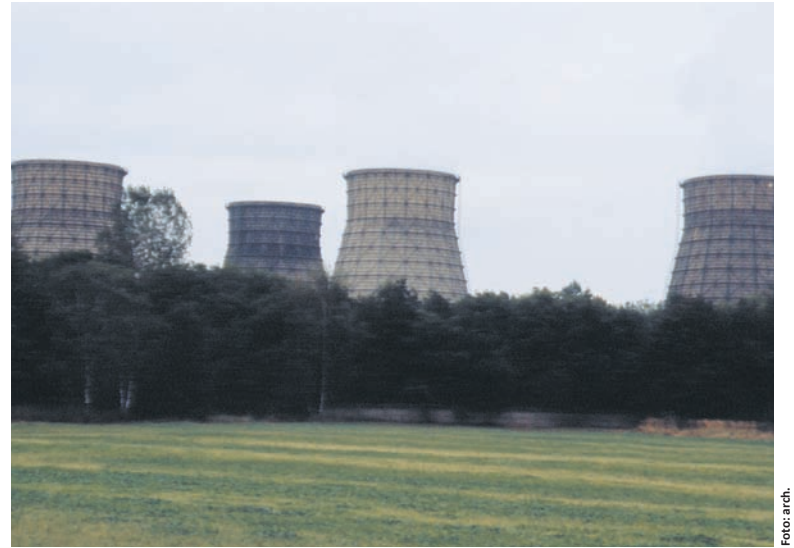
Elektrownia Halemba została wyburzona w 2015 roku. Później powstało składowisko.
