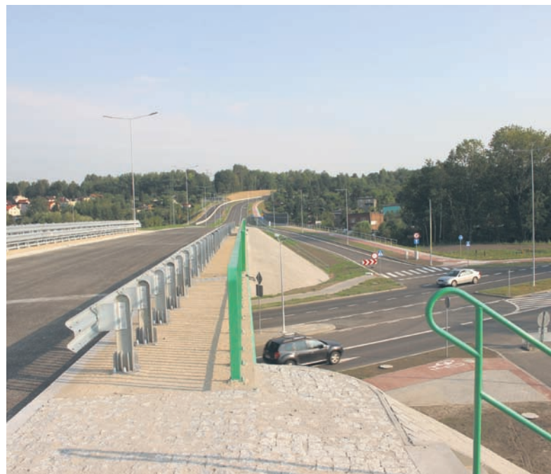
Nowy odcinek ma 1,4 km długości. Kierowcy będą mogli już niedługo trasą N-S dojechać do ulicy Kokota.
