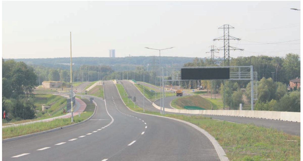
Zainstalowana tablica interaktywna informować będzie kierowców o warunkach pogodowych oraz o utrudnieniach drogowych.
