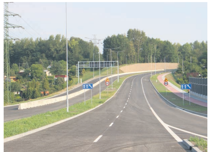
Aktualnie na budowie trwają ostatnie prace montażowe. Wykonywane jest również oznakowanie drogi.
