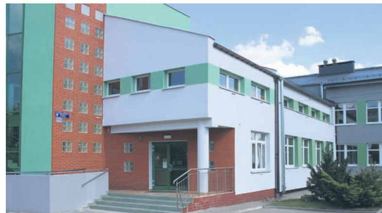
Na 77 rudzkich placówek oświatowych termomodernizację przeprowadzono w 56 budynkach.
