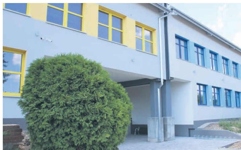
Szkoła Podstawowa nr 16 już po termomodernizacji.
