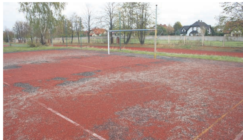
Zniszczone boisko przy Szkole Podstawowej nr 30 będzie całkowicie przebudowane.
