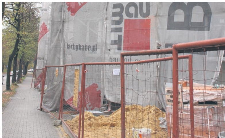
Trwają prace przy termomodernizacji budynków przy ul. Matejki 2a i 2b.
