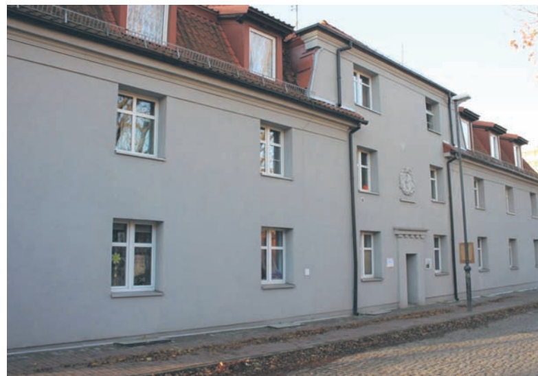
Sąsiadujące ze sobą budynki przy ul. Kubiny 31 i Różyckiego 19 zostały ocieplone oraz podłączone do sieci c.o.
