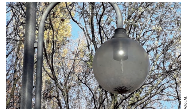
W Parku Mickiewicza zostanie zainstalowane oświetlenie typu LED.
