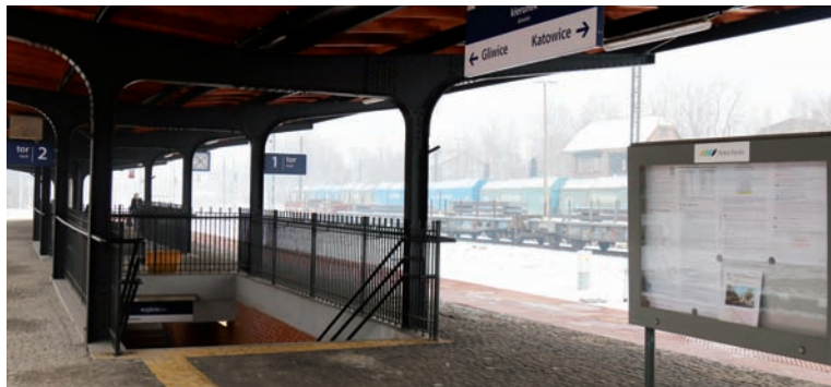
Na schodach przy wejściu na peron brakuje podjazdu dla wózków.
