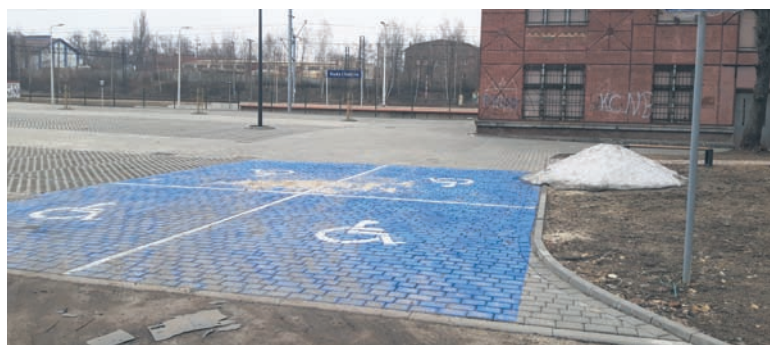
Miejsca parkingowe przy dworcu właśnie są tworzone.
