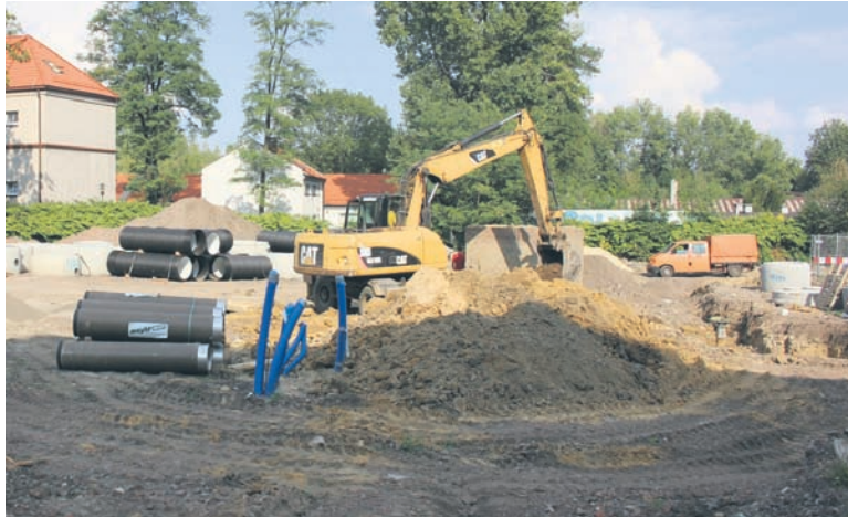
Pozyskane przez miasto 43 mln zł przeznaczone zostaną na budowę 19 km kanalizacji deszczowej i 21 zbiorników retencyjnych.
