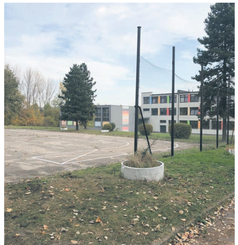
Teren przy Zespole Szkół Ponadgimnazjalnych nr 2 przejdzie gruntowną modernizację.
