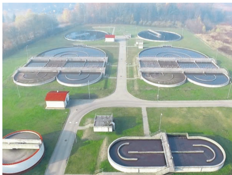
Budowa nowej oczyszczalni ścieków w Halembie także została dofinansowana środkami z UE.
