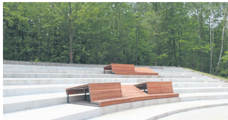
W ramach prowadzonych prac wyremontowano schody amfiteatru.
