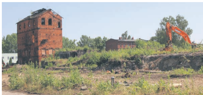
Prace na terenie dawnej koksowni trwają.
