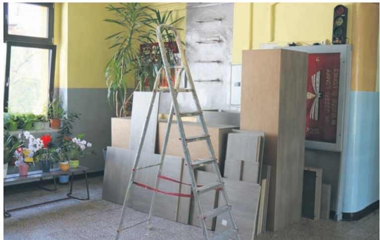
Remont trwa m.in. w Szkole Podstawowej nr 4.
