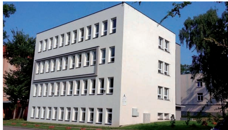
Nowa odsłona rudzkiej psychiatrii. W Bielszowicach przeprowadzono kompleksową termomodernizację dwóch budynków szpitalnych. Koszt tej inwestycji to ponad 3 mln zł. 85 proc. kosztów kwalifikowanych pokryły środki unijne.
