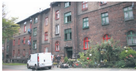
Pożar wybuchł w kamienicach przy ul. Podgórze.
