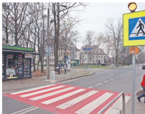
Jedno z objętych projektem przejść znajduje się na ulicy Katowickiej.
