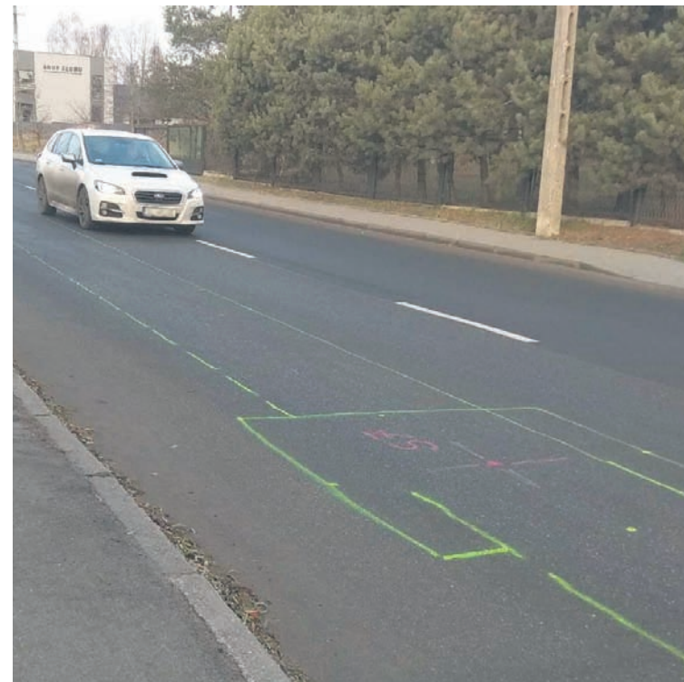
W ramach zadania najpierw wytyczona została sieć kanalizacyjna w ul. Kłodnickiej.
