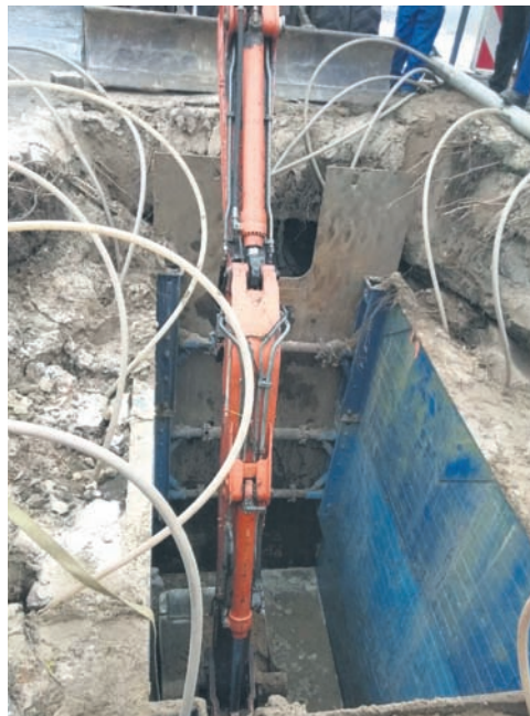
Budowa kanalizacji realizowana jest obecnie przy ul. Szczudlaka.
