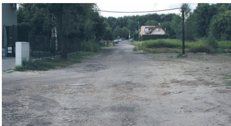
Obecna droga gruntowa, która łączy ul. Kingi i na Piaski, zostanie utwardzona, powstanie też chodnik i nowe oświetlenie.
