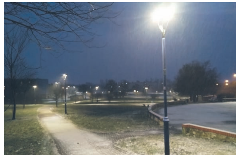
Przez ostatnie dwa lata m.in. zmodernizowano oświetlenie na rudzkim odcinku Drogowej Trasy Średnicowej, na trasie N-S między ul. 1 Maja a DTŚ oraz w centrum miasta.
